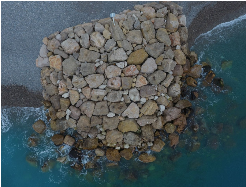
1. État initial de l'ouvrage
